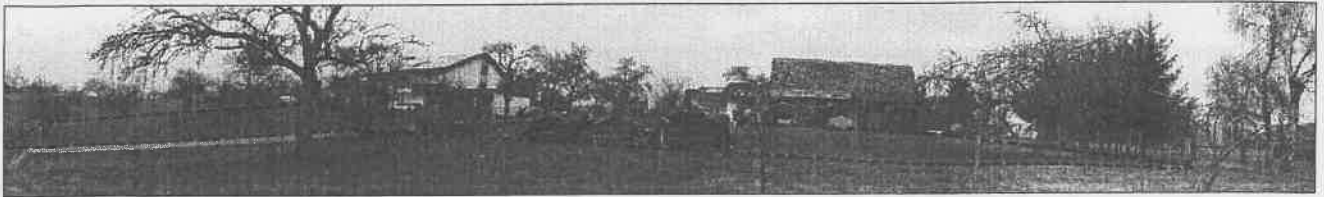
Ansicht aus Süden auf das Flurstück Nr. 224
